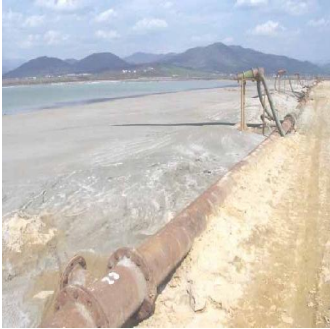
Hidrocicloane amplasate pe digul iazului
